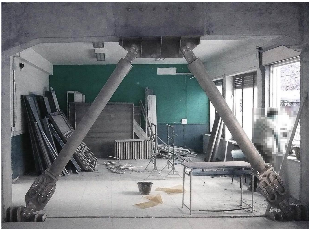
Installazione di controventi dissipativi
