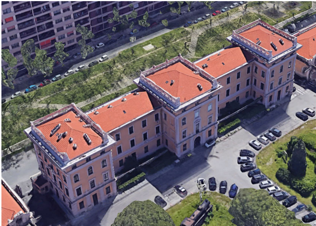
Fig. 3 – Vista aerea dell'Edificio B – area d'intervento
