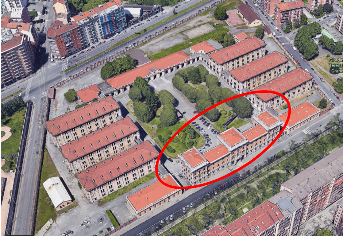
Fig. 2 – Vista aerea dell'Edificio B
