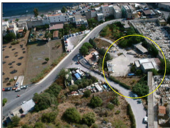
Comune di Lipari isola di Lipari – località Balestrieri. Impianto di depurazione.
