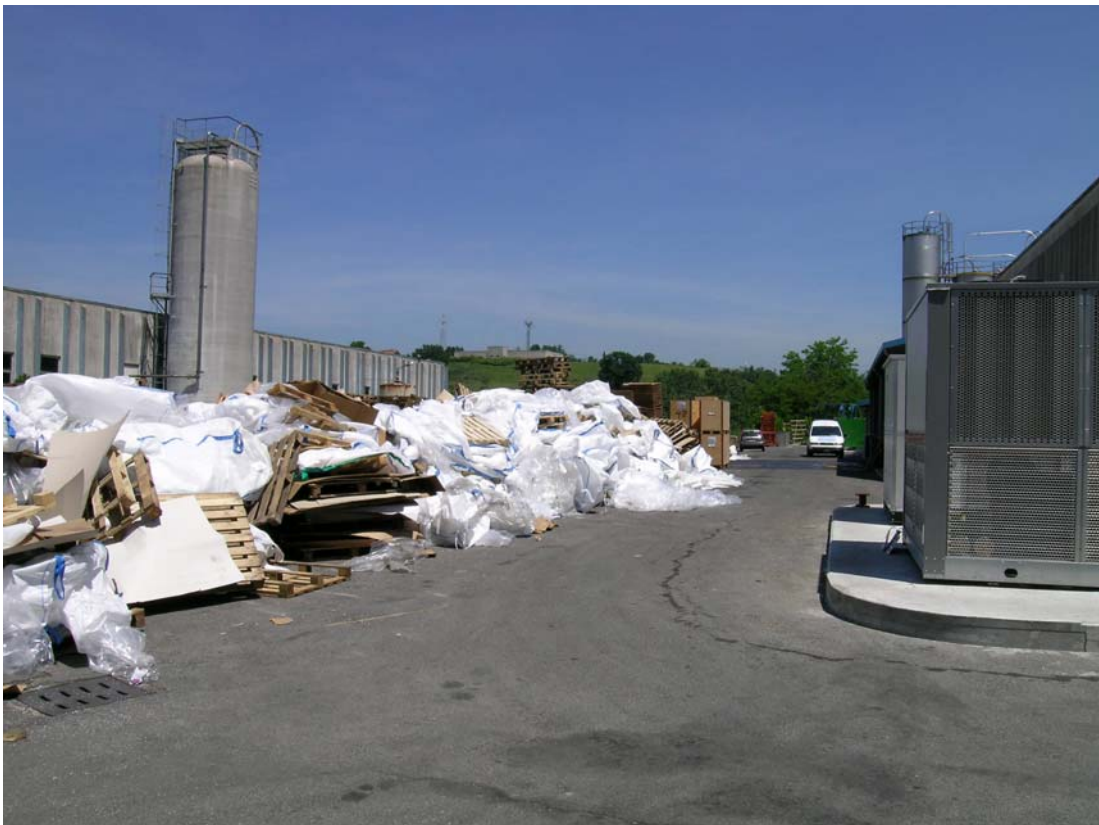
FOTO N.6: Deposito incontrollato di rifiuti sequestrato in località Morolese.
