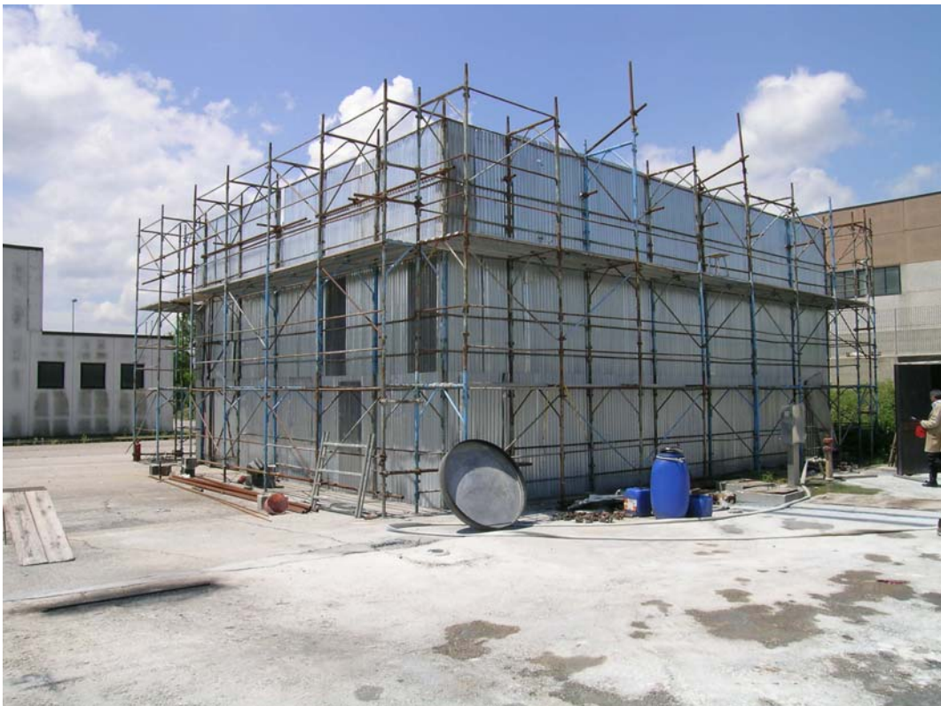
FOTO N.10: Costruzione abusiva sequestrata, località Sgurgola.
