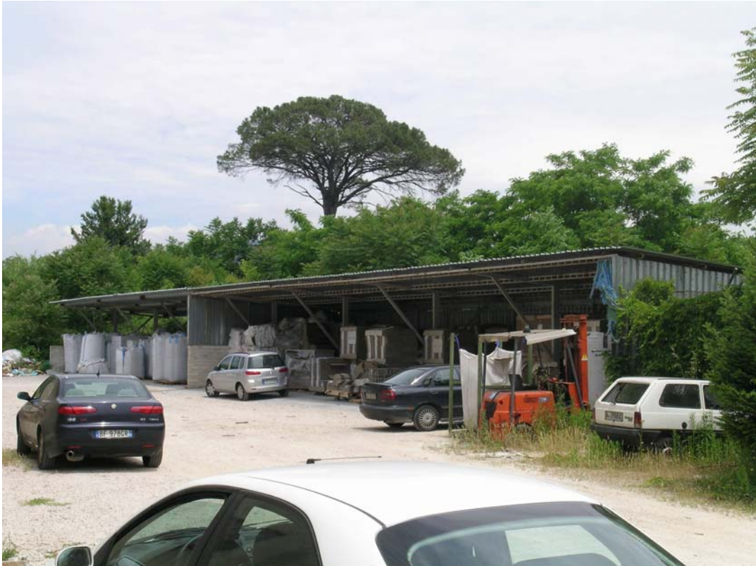
FOTO N.7: Costruzioni abusive sequestrate, località Paduni.
