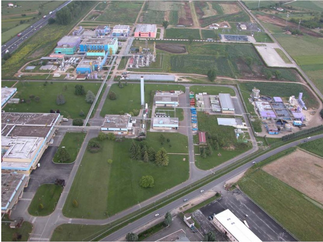
FOTO N.3: Foto aerea degli stabilimenti industriali nel polo di Anagni.
