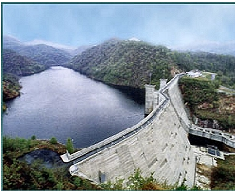
FOTO N. 72: Immagine della diga di delimitazione del Lago di Ponte Fontanelle.
