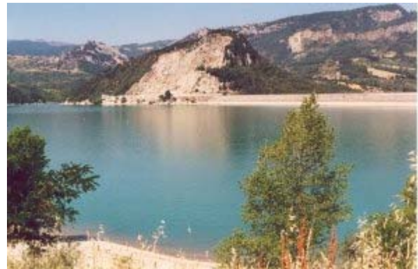
FOTO N. 55: Inquadratura della parte sinistra della diga
