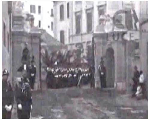
INAUGURAZIONE DELLA CASERMA “PODGORA” ALLA PRESENZA DEL RE
