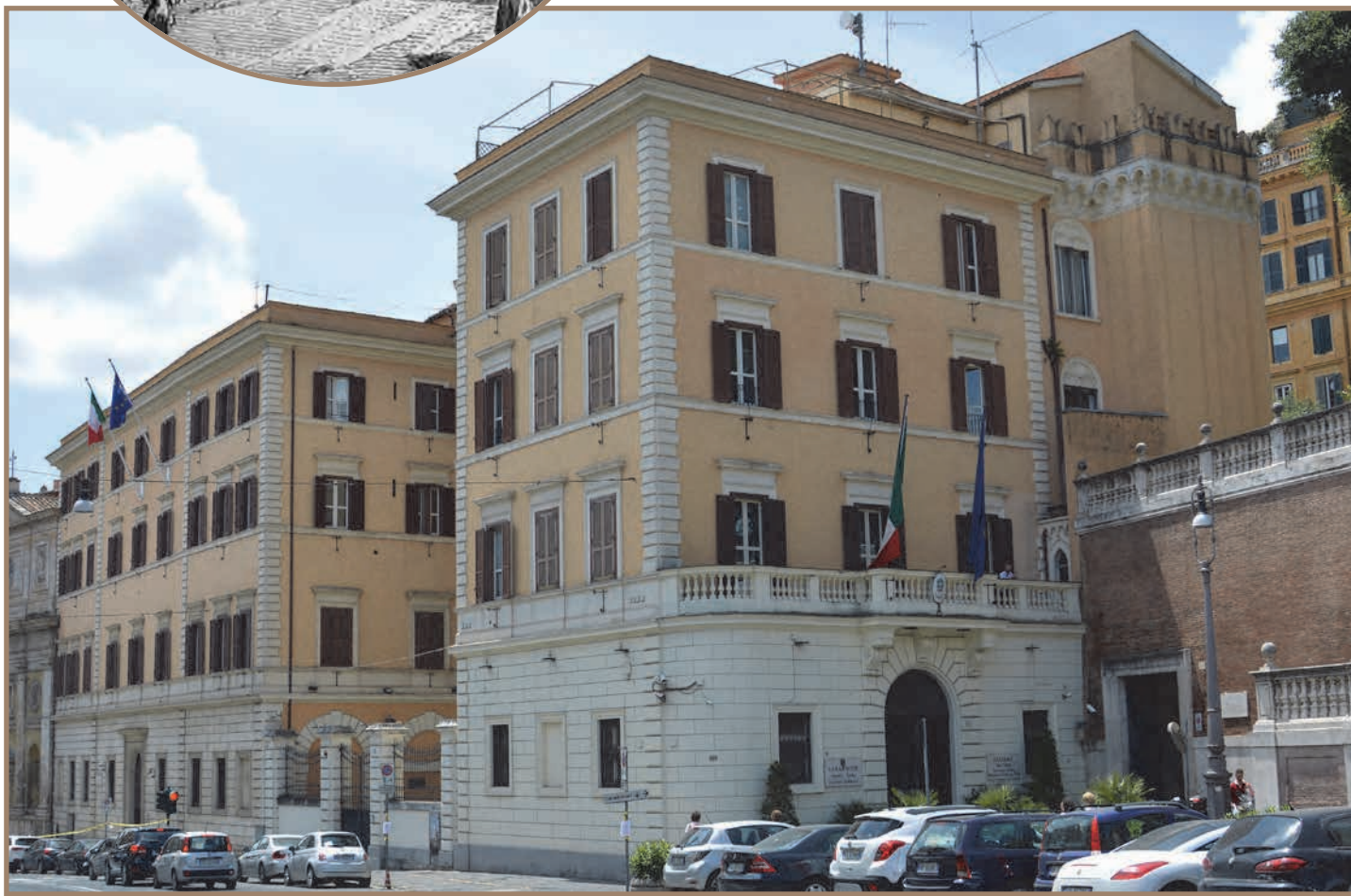
ROMA, VIA XXIV MAGGIO, L'ATTUALE SEDE DEL GRUPPO DI ROMA ACCANTO AL QUIRINALE, NELLA SEDE CHE ERA STATA DEL COMANDO GENERALE
