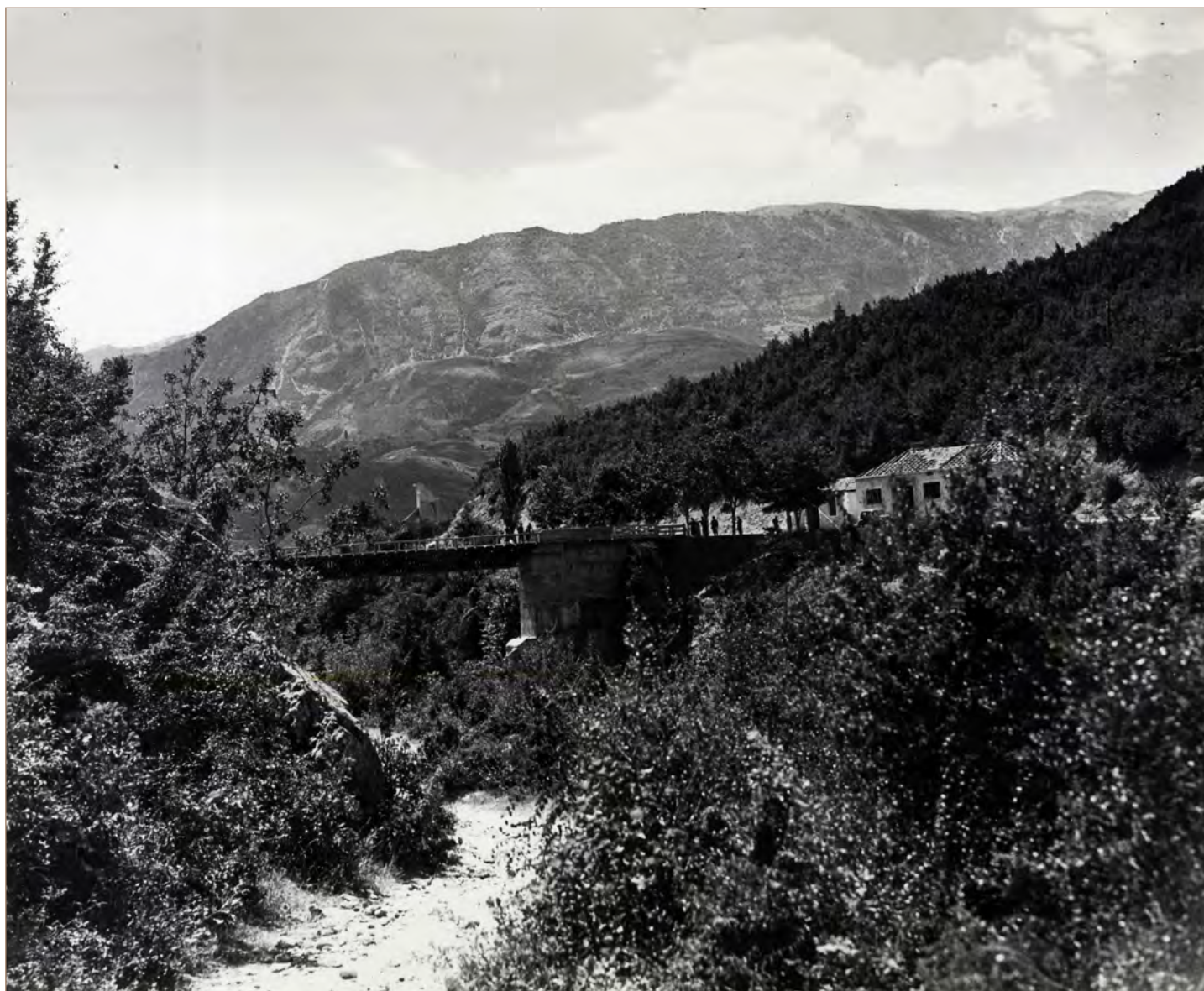
UNA FOTO DEL CONFINE GRECO ALBANESE DOVE IL III BATTAGLIONE SOSTENNE CRUENTI COMBATTIMENTI
