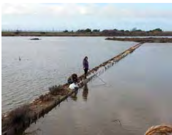
Fig. 4 - Ricercatrici durante un campionamento nei mesi invernali. È possibile notare il deterioramento dei muretti di confine tra vasche attigue determinato dall'assenza di manutenzione degli argini che una volta veniva garantita dalla produzione del sale.
