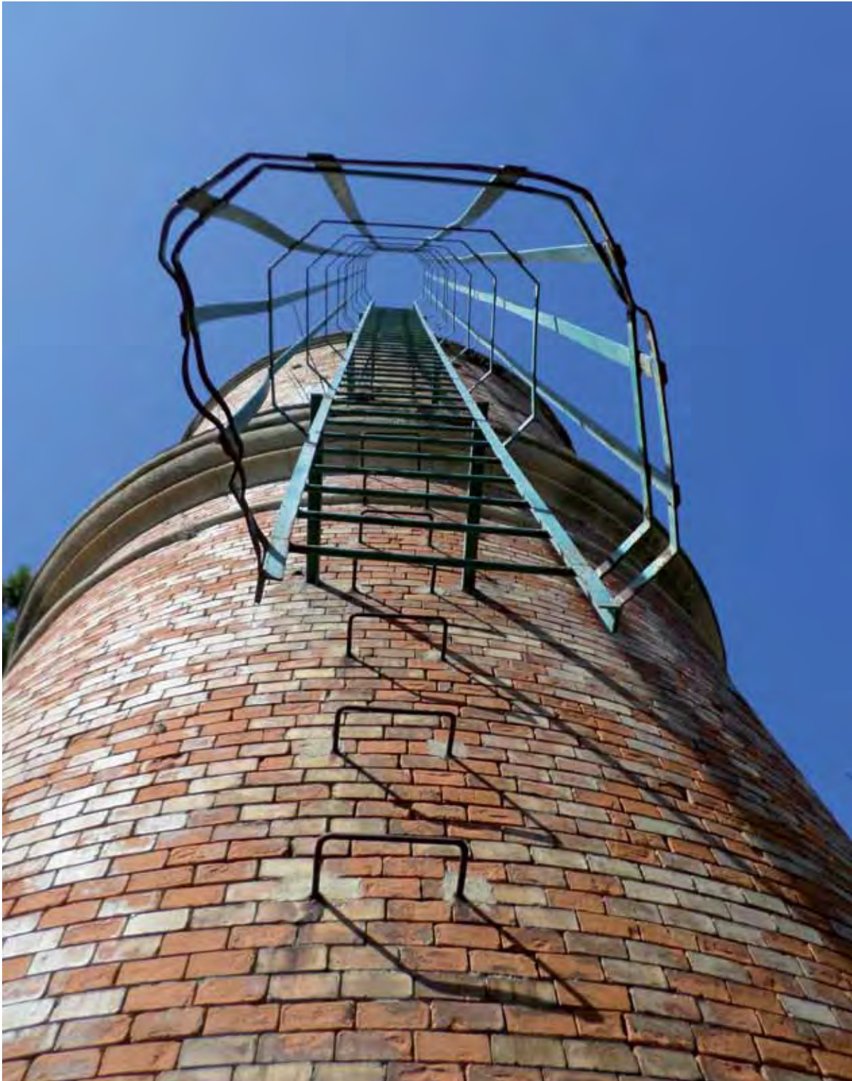
Fig. 7 - Torre del serbatoio dell'acqua costruita nel 1925.
