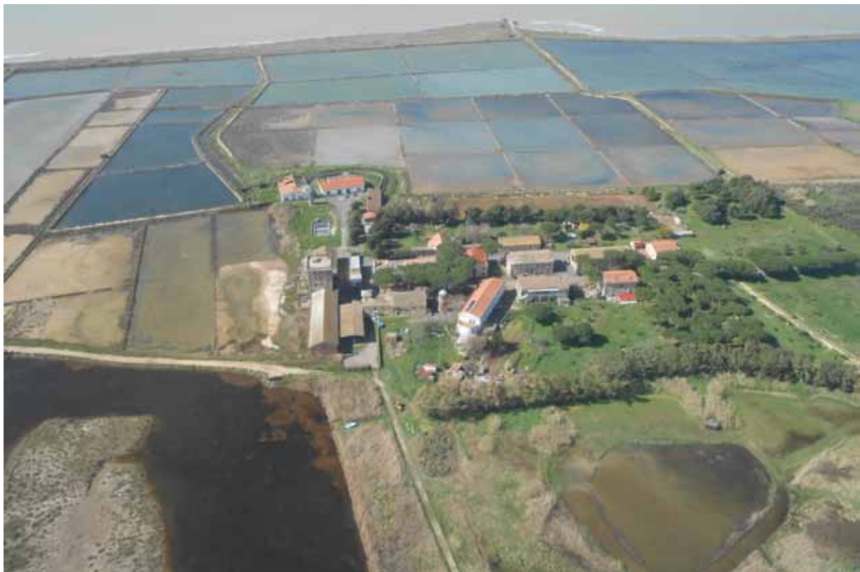
Fig. 13 - Immagine aerea del borgo della Riserva nel marzo del 2013.
