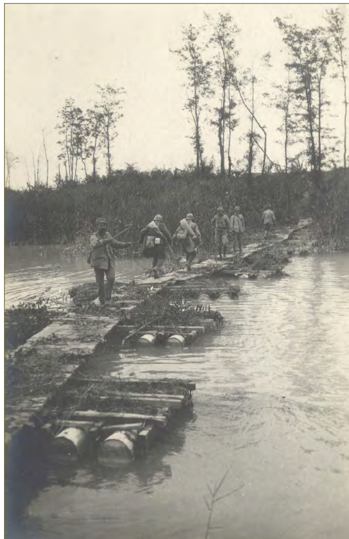
PASSERELLA DI ZATTERE PER L'ATTRAVERSAMENTO DEL PIAVE
