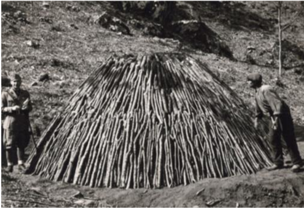
Figura 3: La “costruzione” e la fase di combustione realizzazione della carbonaia avveniva in epoca passata spesso sotto il controllo dell’Amministrazione Forestale dello Stato. (Foto: Archivio Comando Regione Carabinieri Forestale “Marche” – Ancona).
