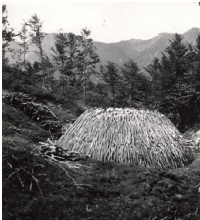
Figura 10: La “costruzione” della carbonaia richiedeva non comune perizia e specifica maestria da parte dei carbonai; si procedeva per successive fasi in cui si sovrapponevano con cura vari “strati” di tondelli incastrati al meglio tra loro per ridurre gli spazi vuoti . (Foto: Archivio Comando Regione Carabinieri Forestale “Marche” – Ancona)
