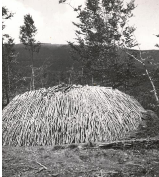
Figura 2: Una volta ultimata la “costruzione” della carbonaia, la stessa veniva ricoperta di terra reperita sul posto; si può notare l’inizio del ricoprimento sul lato sinistro osservando l’immagine. (Foto: Archivio Comando Regione Carabinieri Forestale “Marche” – Ancona)
